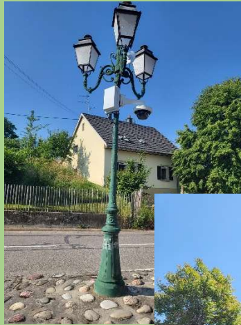
Installation des caméras de vidéosurveillance
