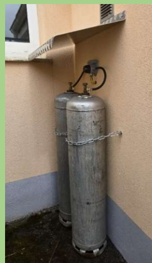
Installation de gaz de secours à la salle communale
